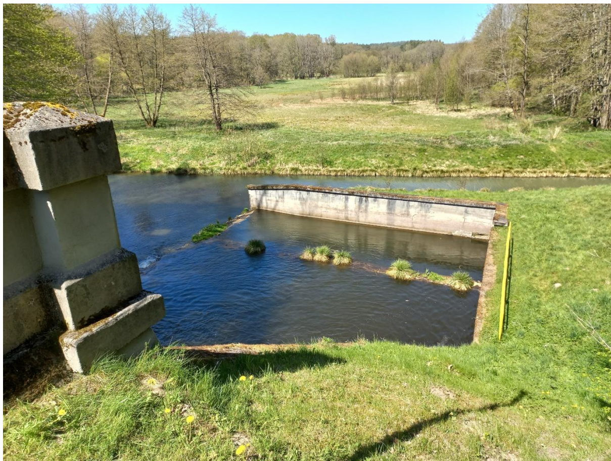
Fot. 3 Widok na dolną kaskadę upustów powierzchniowych zapory
